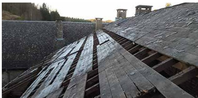
*Alle diese Schieferplatten wurden vom Dach abmontiert, in den Dachboden gereicht und über eine entsprechende Rutsche ins Erdgeschoss befördert, wo sie gestapelt und verpackt wurden.*
