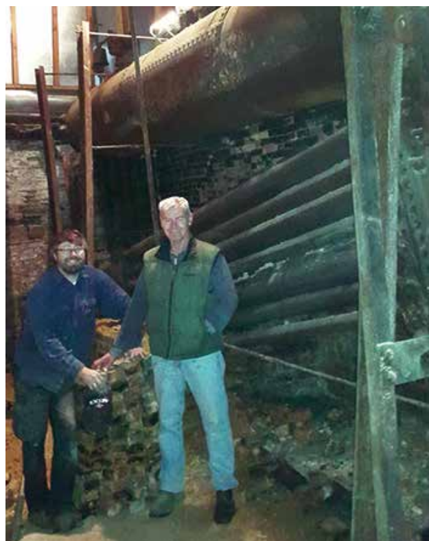
Yves Claude et Luc Thiry devant la dernière pile de briques rouges démontées de la chaudière centenaire. Réaliser ce travail a pris cinq mois.
