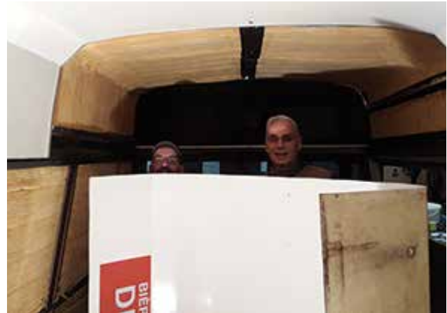
Christophe Herman et Pierre Dejardin avant la fixation du faux plafond au toit du camion.
